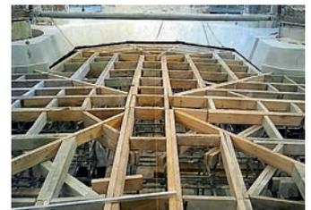
2 Montaje de la estructura principal de madera que sustenta la cúpula durante su construcción y posterior fraguado.
